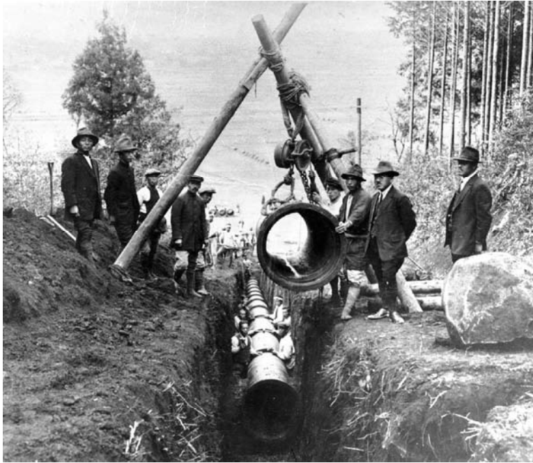
八景水谷送水管布設工事（大正期）
